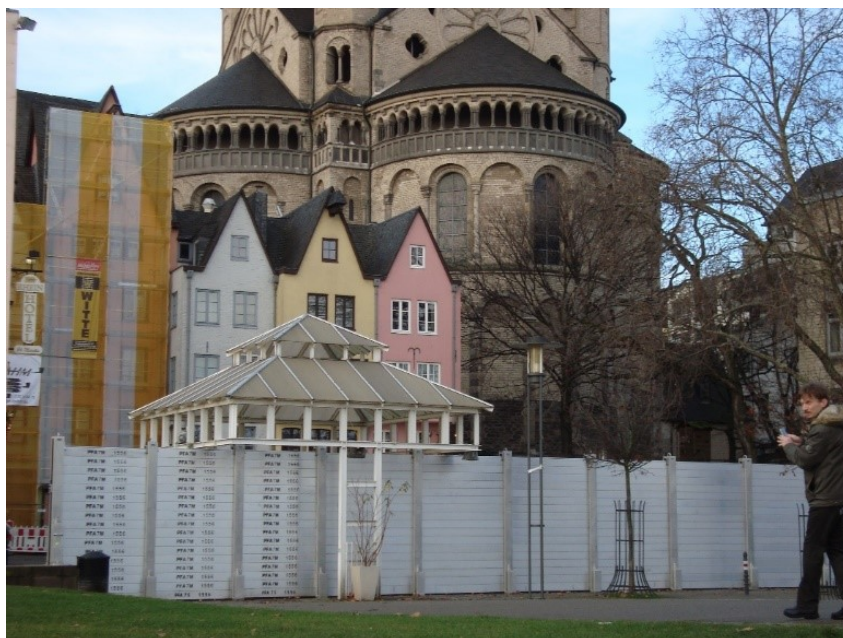
Abbildung 1.2.: Mobiler Schutzwall gegen Rheinhochwasser in Köln.
